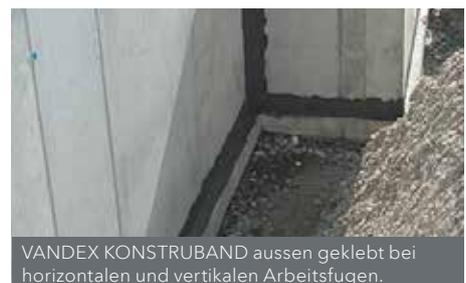
VANDEX KONSTRUBAND aussen geklebt bei horizontalen und vertikalen Arbeitsfugen.
